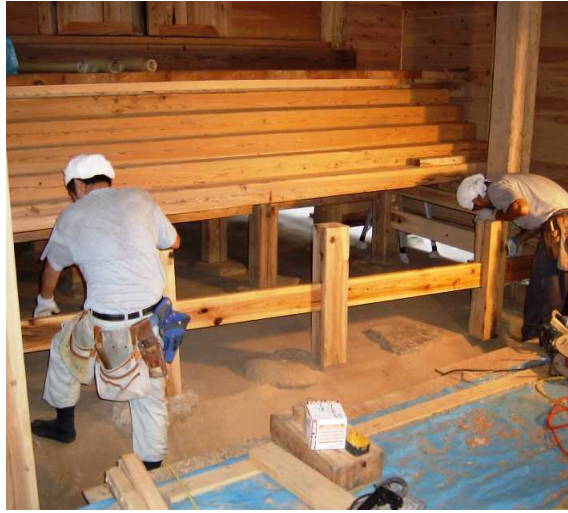
本殿の階段は既存のものを削って使用し、交換した構造材も従来の寸法を再現
